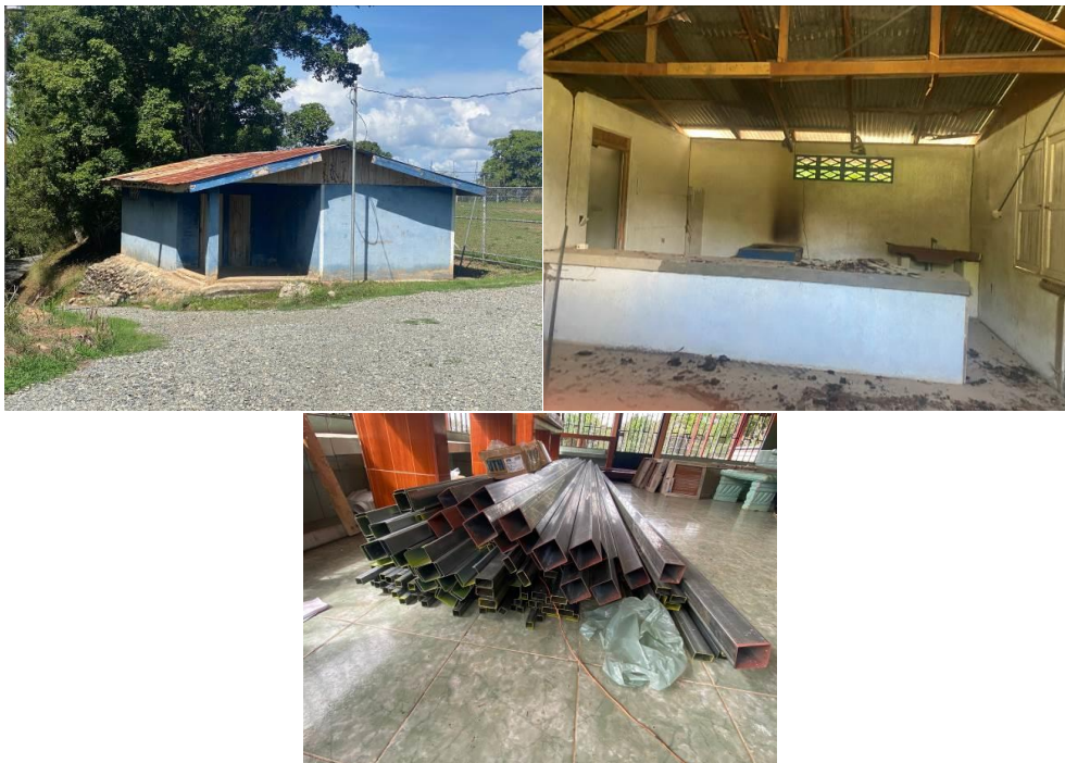
Atención, visita para la revisión de necesidades y entrega de materiales para la “Remodelación y mejoras de los camerinos y bodega de la Asociación de Productores de Pueblo Nuevo, Distrito Potrero Grande”
