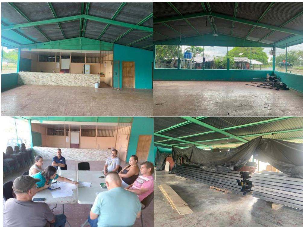
Atención, visita para la revisión de necesidades y asesoría para la construcción de la “Remodelación al Salón Comunal de Potrero Grande, Distrito Potrero Grande”
