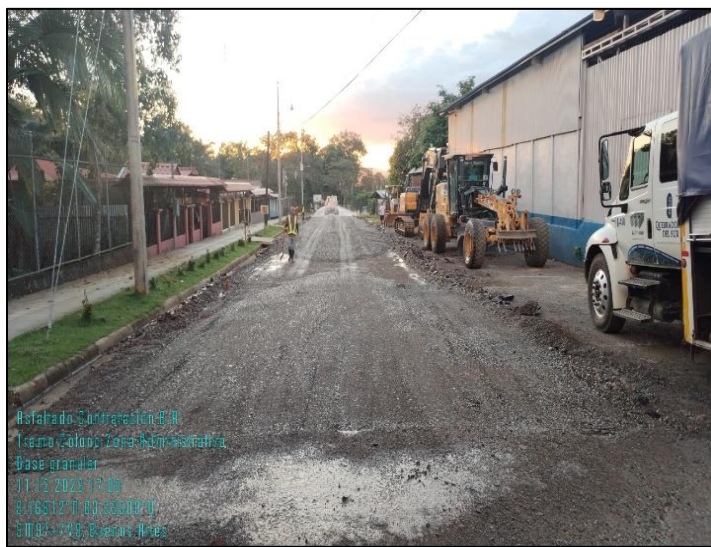
Camino 6-03-038 Sector Zona Administrativa (Antes)
