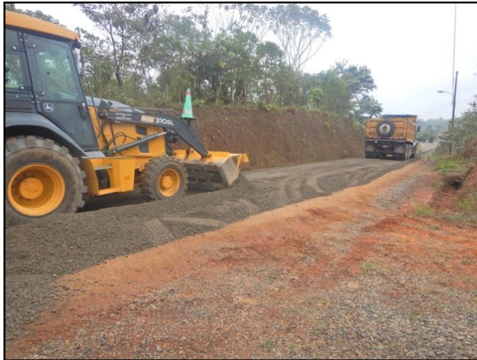
Camino: 6-03-059, Puente Río Convento LMTE
