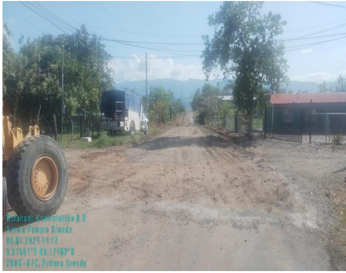
Camino 6-03-217 Potrero Grande TSB3 (Antes)
