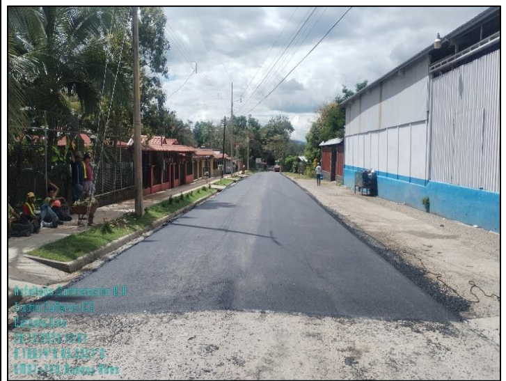
Camino 6-03-038 Sector Zona Administrativa (después)
