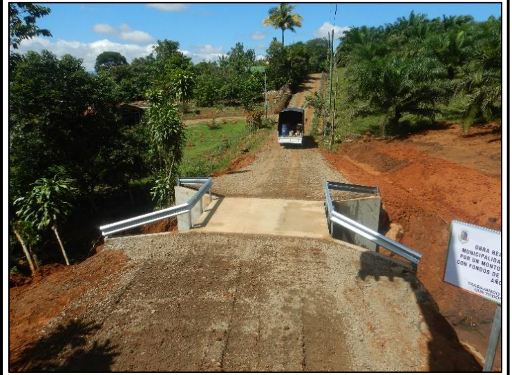
Camino 6-03-110 Cordoncillo (Después)
