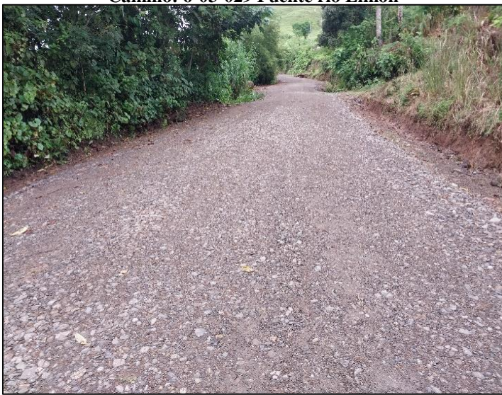
Camino: 6-03-029 Puente río Limón
