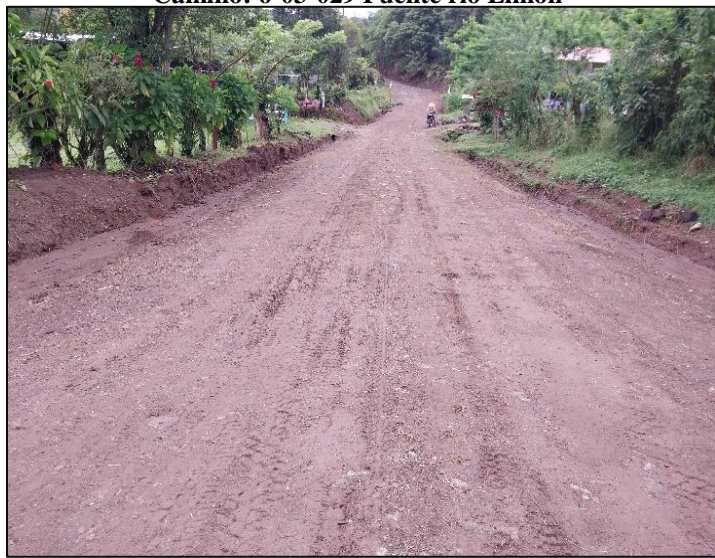
Camino: 6-03-029 Puente río Limón
