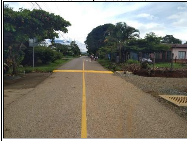
Línea de centro y pintura de reductor
