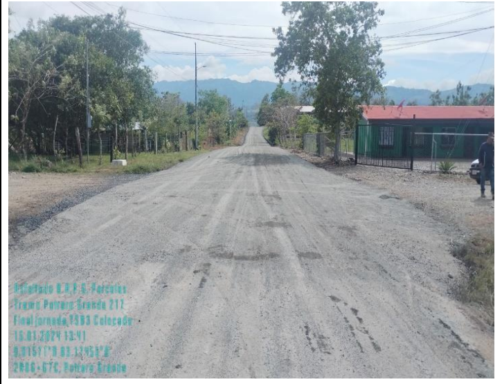
Camino 6-03-217 Potrero Grande TSB3 (después)
