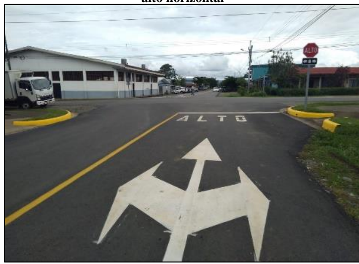
Línea de centro, flecha direccional, cordón y caño y señal de alto horizontal
