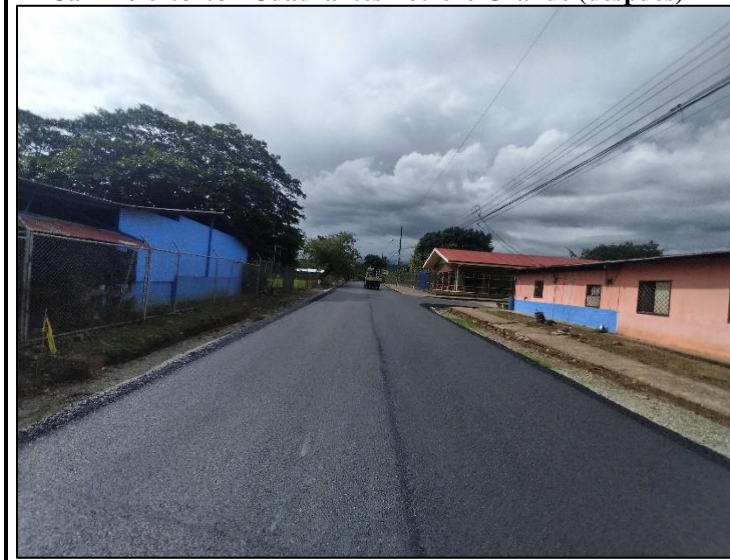
Camino 6-03-031 Cuadrantes Potrero Grande (después)
